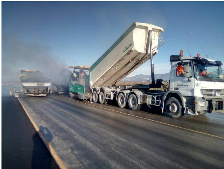
Dettaglio della fornitura in cantiere, aeroporto militare di Ghedi (BS)
