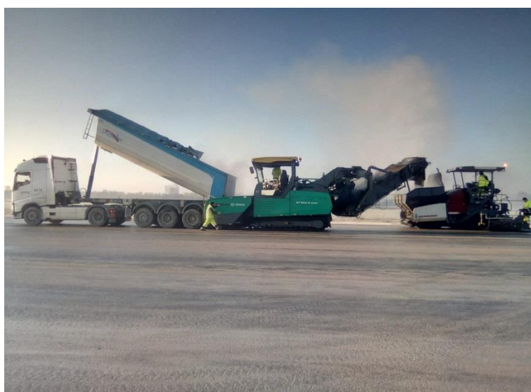
Asfaltatura della pista aeroporto militare di Ghedi (BS)
