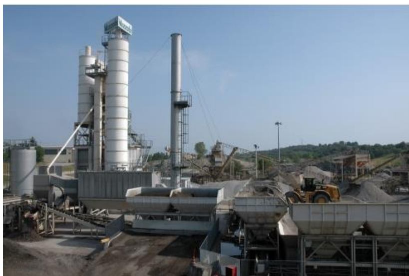
L'impianto della Vezzola Spa a Lonato del Garda (BS)
