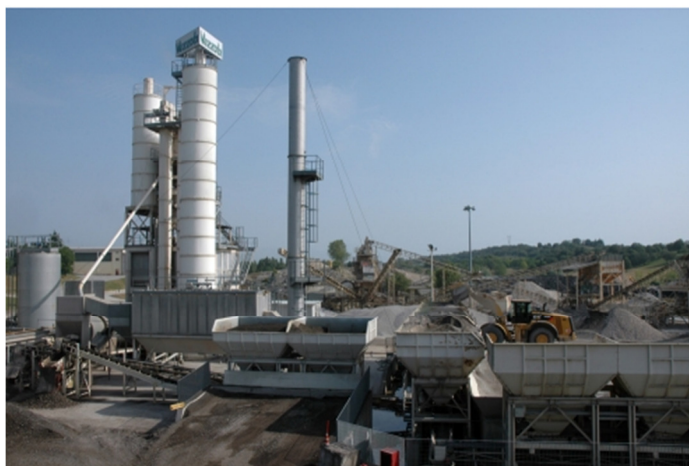
L'impianto della Vezzola Spa - Lonato del Garda (BS)
