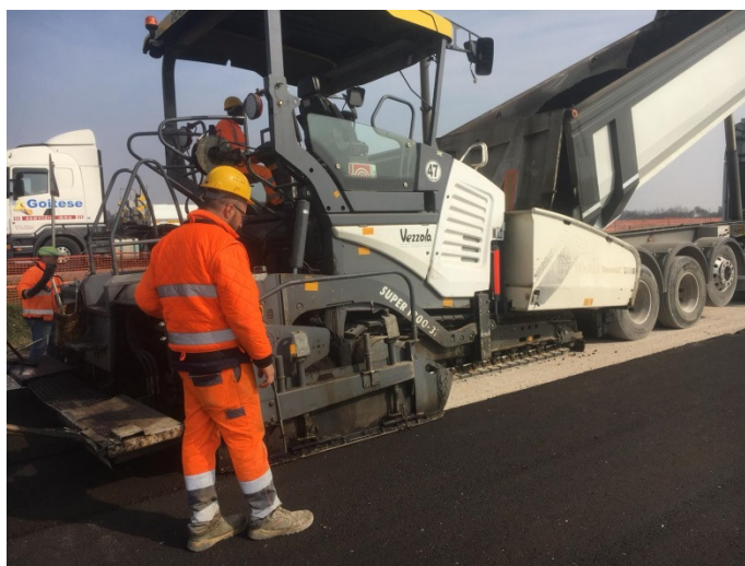
Stesa dell'Ecobase con vibrofinitrice - Cantiere SS236 - Guidizzolo (MN)
