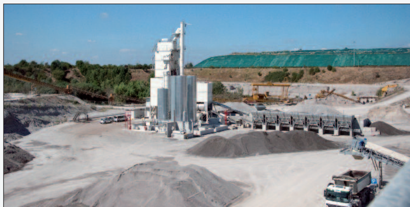
4. Una vista del cantiere
